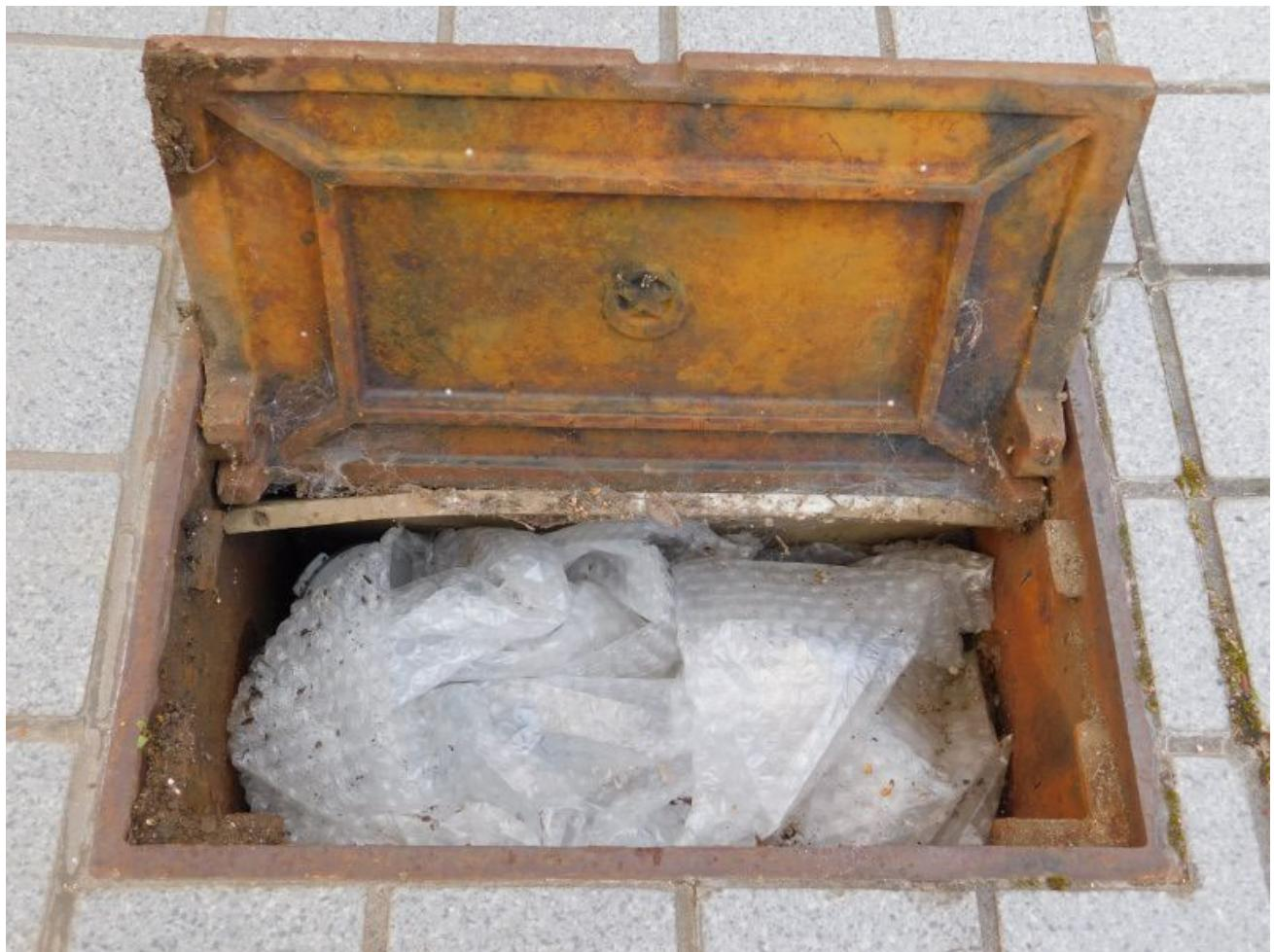
★屋外の水道に断熱材を巻き付けて厳重に防寒対策をした事例
